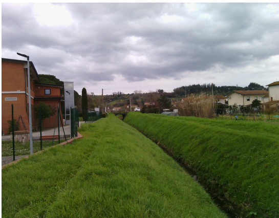
Tratto a valle del ponte sulla SR 436 (in lontananza)
