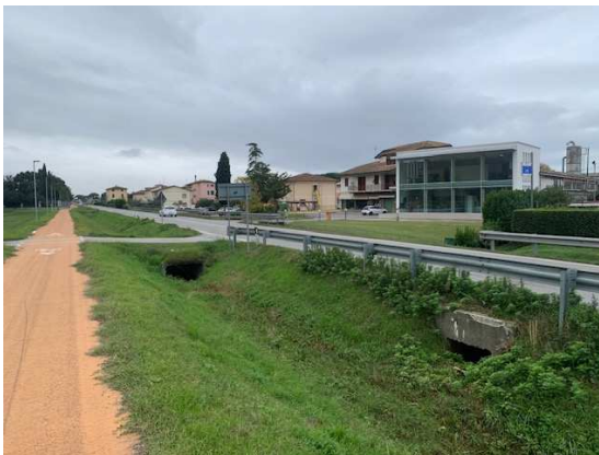
Particolare del Fosso B con attraversamento della SR 436 verso Fosso C_monte
