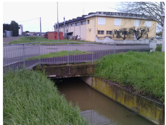
Attraversamento del Fosso C2 su Via Pacinotti
