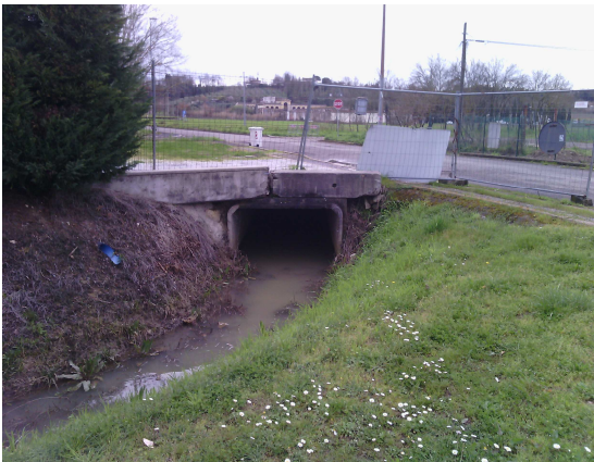
Attraversamento del Fosso C3 su Via Copernico
