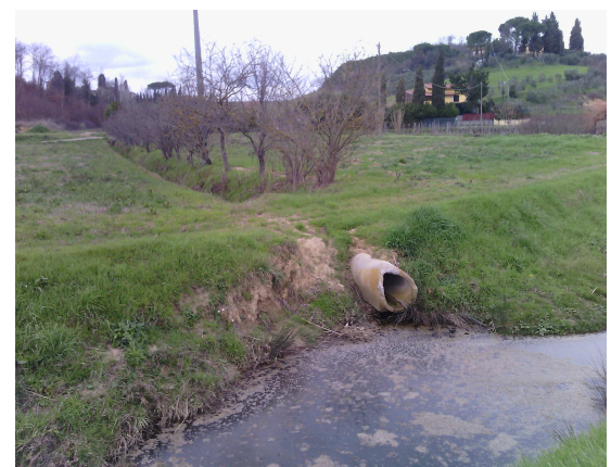
Particolare scarico affluente destro
