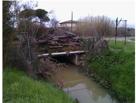
Attraversamento a valle del tratto urbano con scatolare
