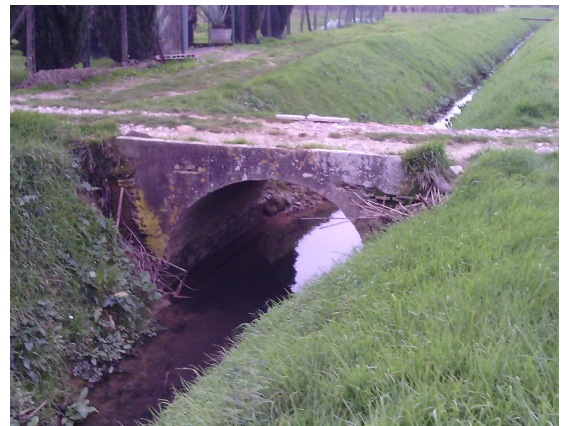
Ponticello su strada campestre (fine tratto studiato)
