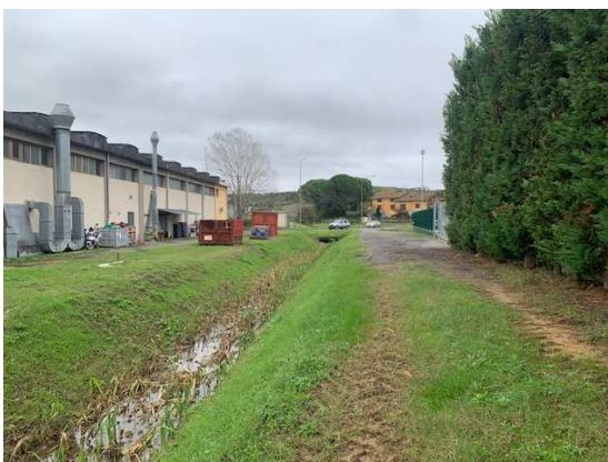
Particolare del tratto a valle della SR 436 ed a monte della confluenza con C3
