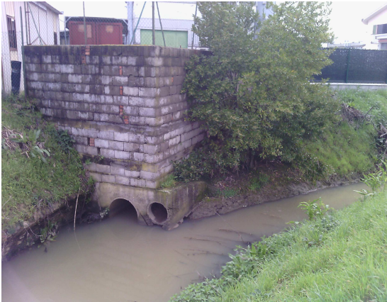
Particolare di scarico fognario da area urbana Botteghe su Fosso C2_valle
