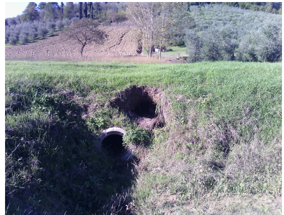
Particolare altro scarico e dissesto arginale
