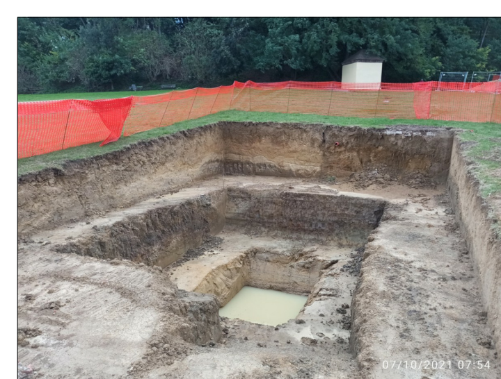
F.12. Panoramica del Saggio S12 effettuato per le verifiche archeologiche del sito. Sono ben evidenti le anglie dello strato S1, con intercalazioni sabbiose verso la parte bassa.
