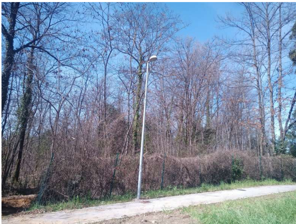
Sotto vista dell'area ZSC interessata dai lavori, con presenza di illuminazione e recinzione esistenti
