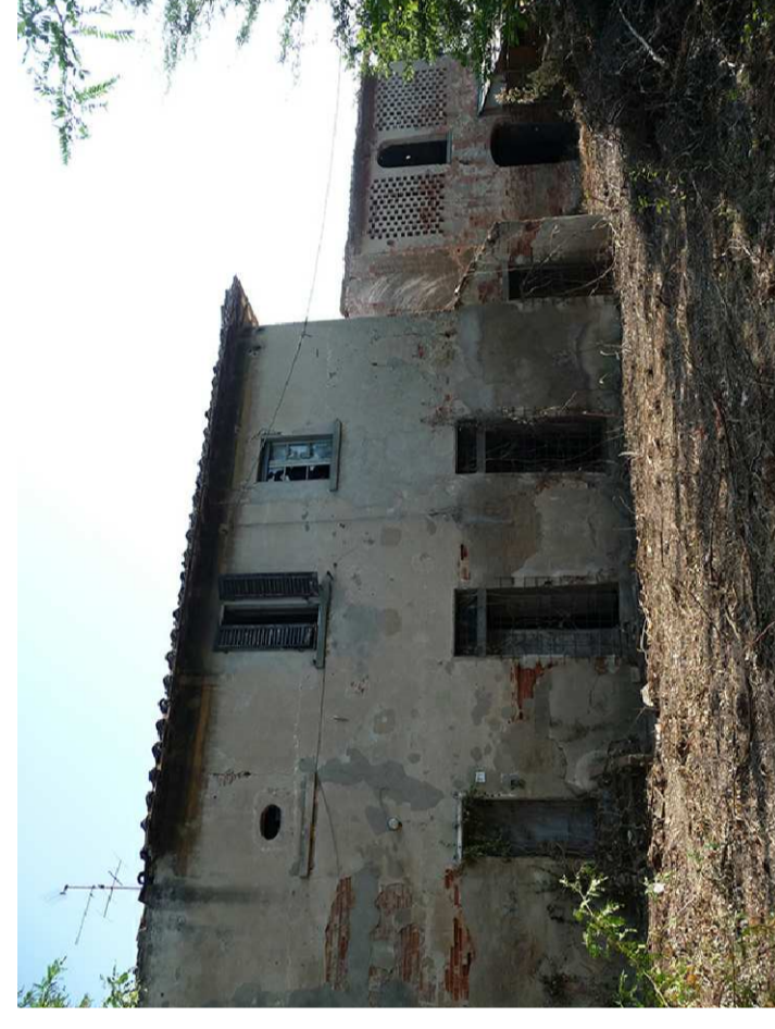
Foto n.5 - parziale del fronte fabbricato principale e pertinenza
