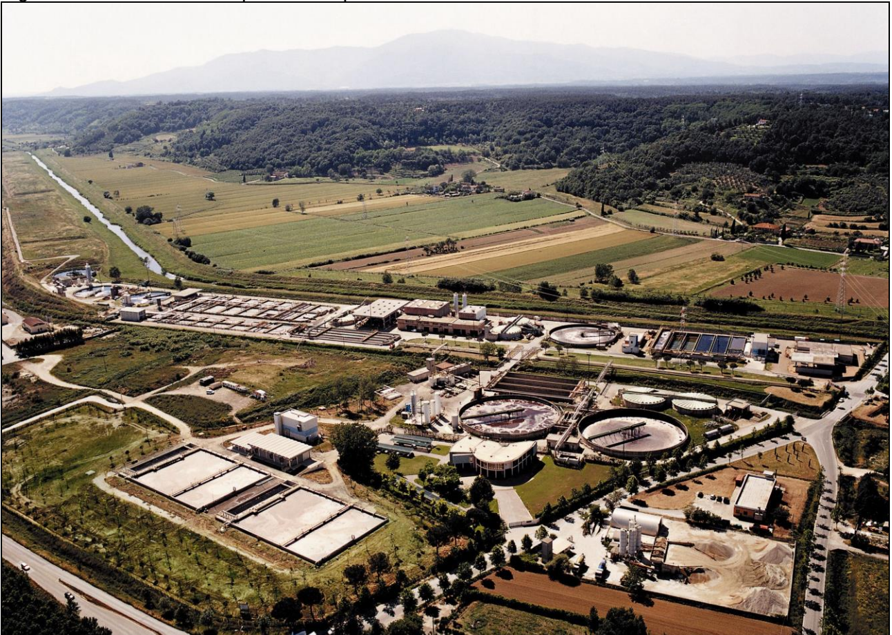
Figura 2. Panoramica depuratore Aquarno.
