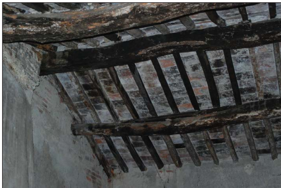
Fig. 1. Controllo delle soffitte nel podere Il Cerro
