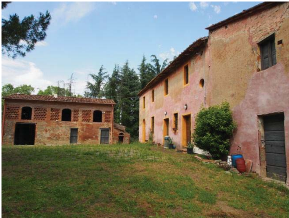
Il fabbricato principale e il fienile
