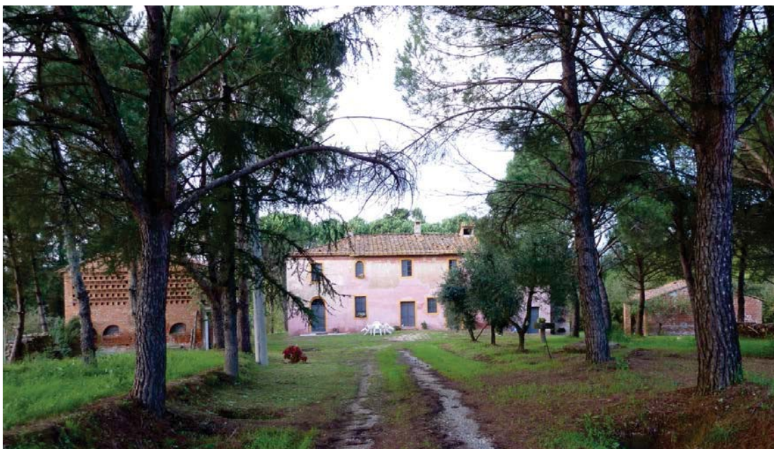
Visuale dei fabbricati dalla viabilità di accesso
