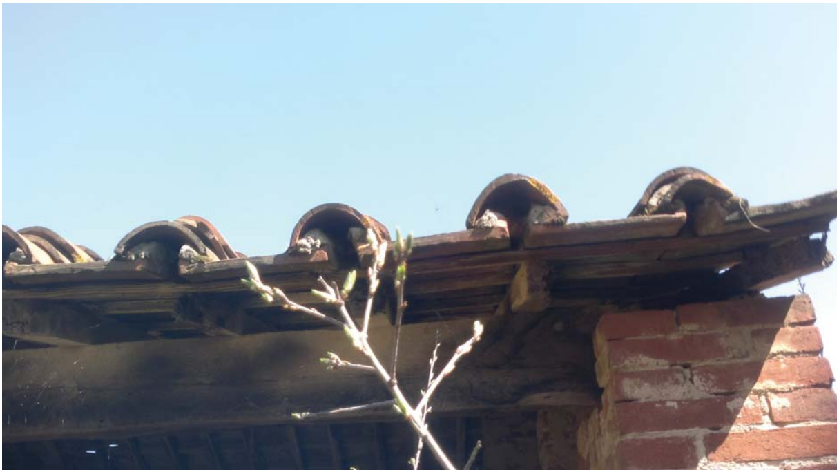
Particolare di coppi e tegole
