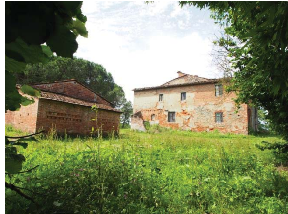
La carraia e il fabbricato principale visti da est
