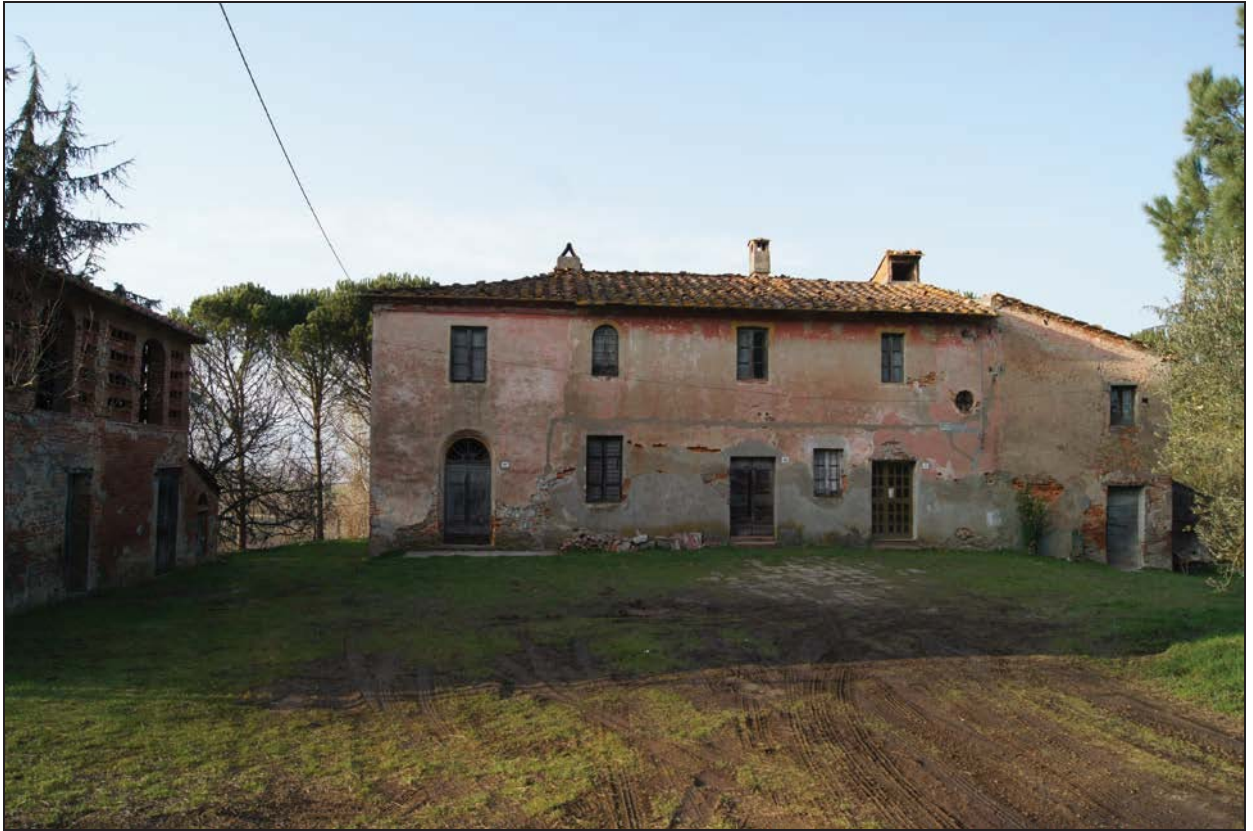
Il fabbricato principale ed ad ovest il fienile
